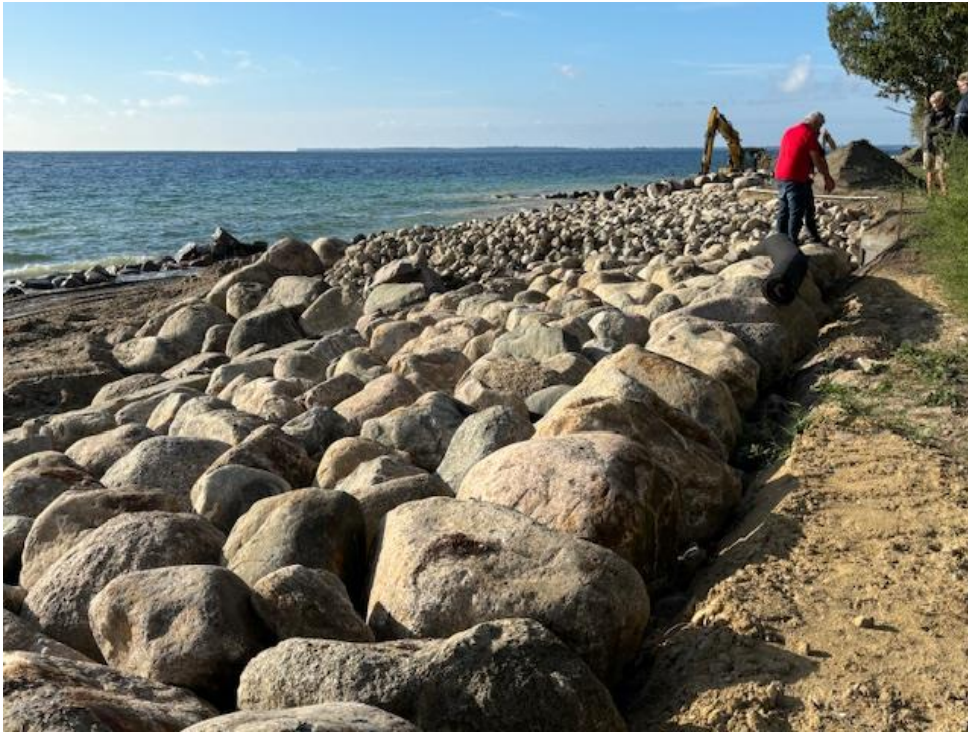
Figur 4-14 Eksempel på anlæg af "brækket" profil med afslutning med store sten op mod terræn. Der mangler her en endelig afretning af jorden op mod stenene.
