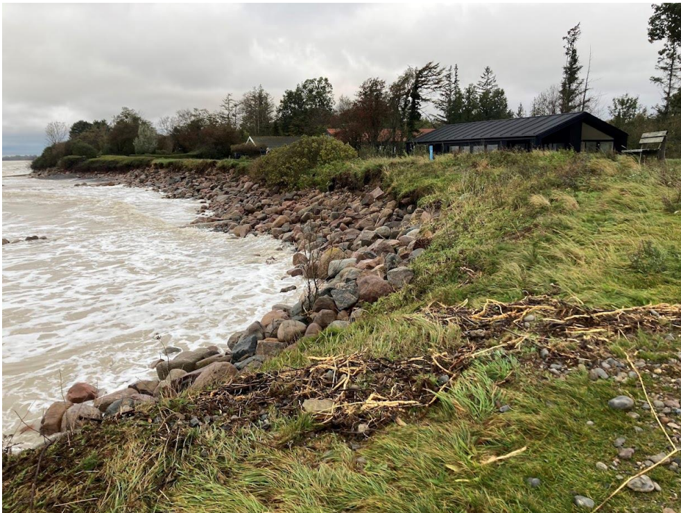
Figur 4-21 Foto fra stormfloden 21. okt. 2023 set mod vest (foto fra digelaget)
