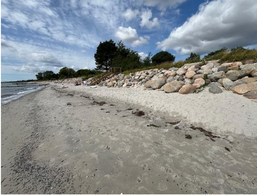
Figur 2-4 Havdiget i lagets vestlige strækning. Det har en kronekote på ca. +3,0 m. Det starter mellem Højde H22 og H23 og løber mod vest til vejen, Hjulsporet
