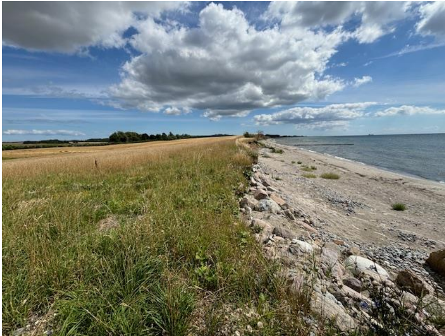
Figur 2-8 Kysten øst for pumpestationen hvor terrænet er relativt lavt og helt ned til +2,75 m på det laveste sted.
