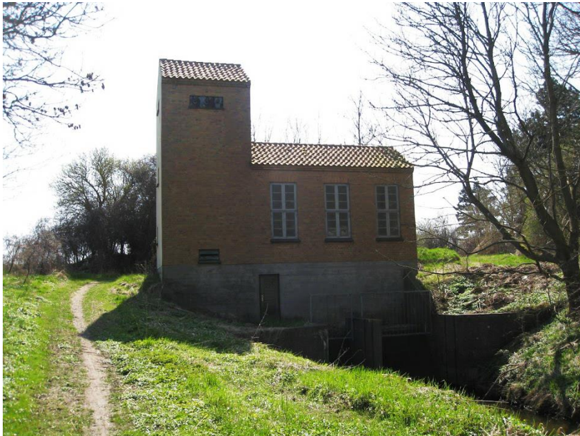
Figur 2-9 Pumpestationen med kanalen til højre (foto fra Google Earth)
