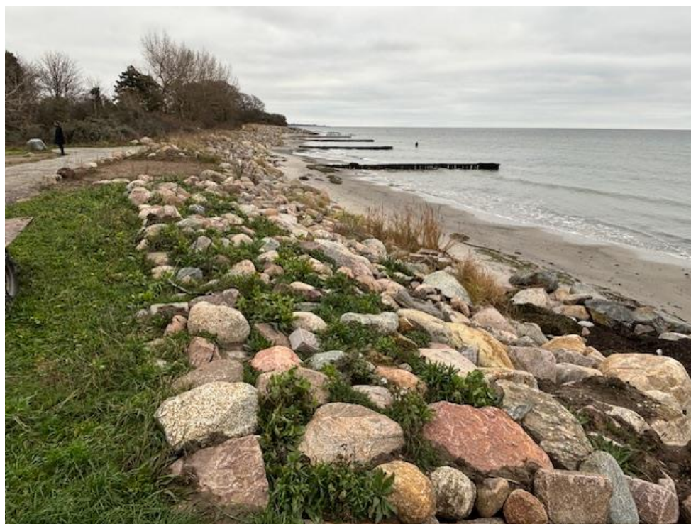
Figur 4-45 Strækningen ud mod havet med lagets pæle/træ-høfder i baggrunden og stenkastningen foran adgangsvejen
