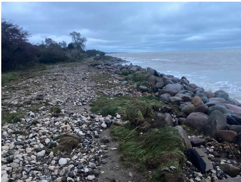
Figur 4-5 Foto af digekronen under stormflodens aftagen. Bemærk kraftig erosion i kronen og mange ral-sten der er flyttet ind over kroen ved kraftigt bølgeoverskyl.
