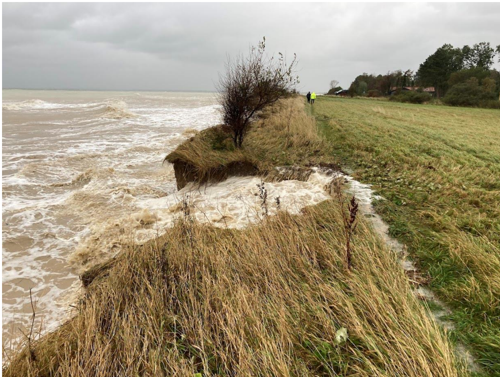
Figur 4-32 Foto af strækningen lige øst for pumpestationen under stormfloden med bølgeopskyl og beskadigelse af kystskrænten
