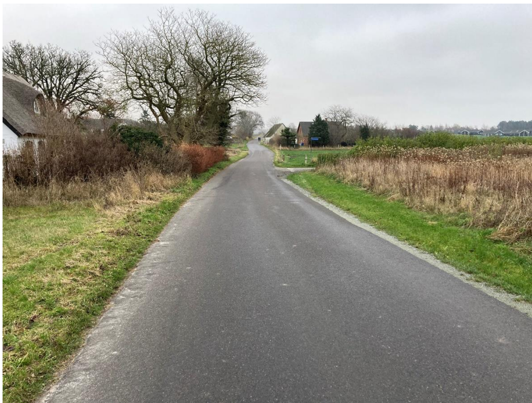
Figur 4-47 Lavningen på Kullegårdsvej set mod vest
