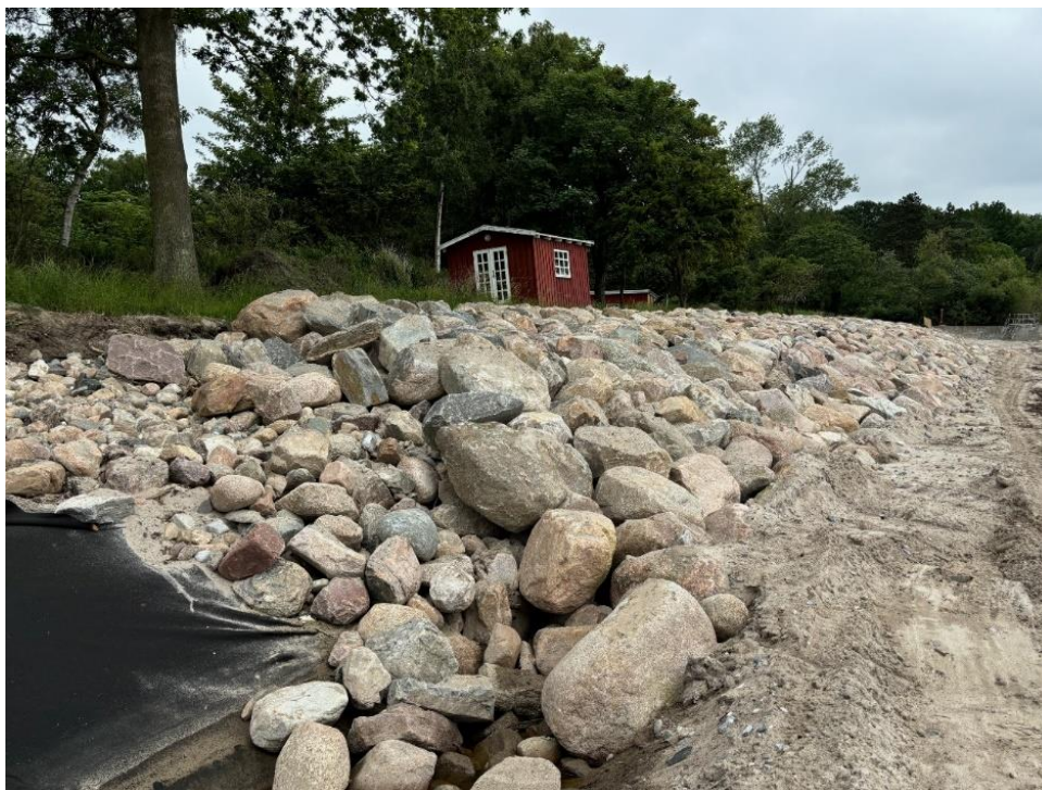
Figur 4-16 Eksempel samme type profil her med lag af mindre sten under dæksten og ovenpå filtersten
