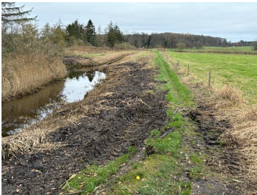
Figur 2-10 Kanalen set mod nord, november 2024 (OJJ)
