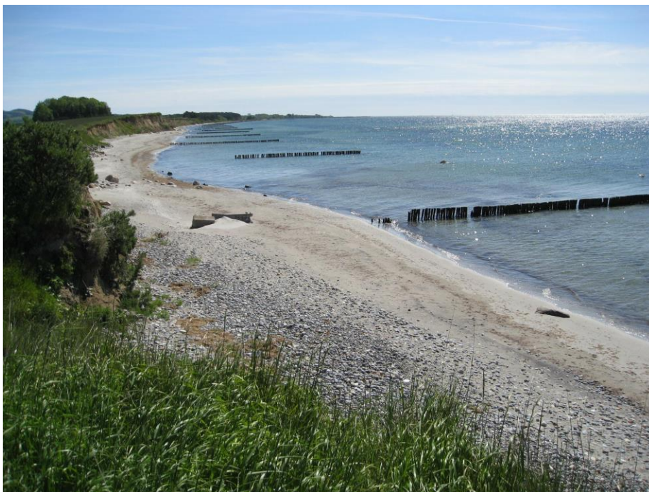
Figur 2-6 Kysten øst for pumpestationen inden stormfloden i okt. 2023. Kysterosionen har medført tilbagerykning, så høfderne ikke mere starter inde på stranden (foto fra Google Earth)
