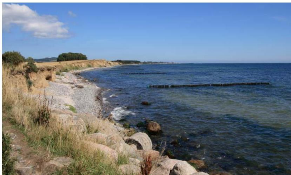
Figur 2-6 Kysten øst for pumpestationen inden stormfloden i okt. 2023. Kysterosionen har medført tilbagerykning, så høfderne ikke mere starter inde på stranden (foto fra Google Earth)
