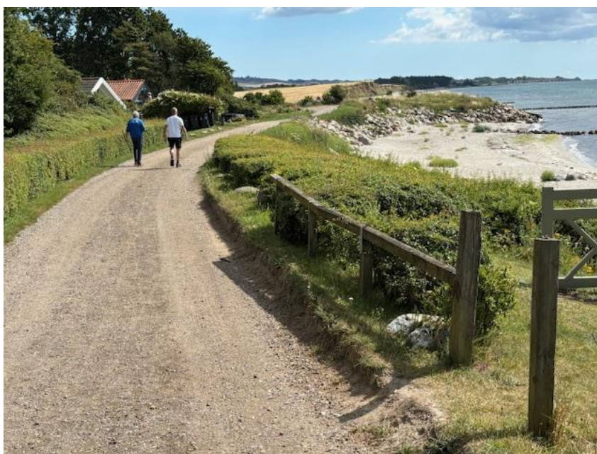
Figur 2-2 Skræntfodsbeskyttelsen mellem høfde 17 og 18, kaldet S 17-18. Man ser den temmelig ujævne stenkastning af store sten i varierende størrelse lagt op mod den naturlige skrænt.
