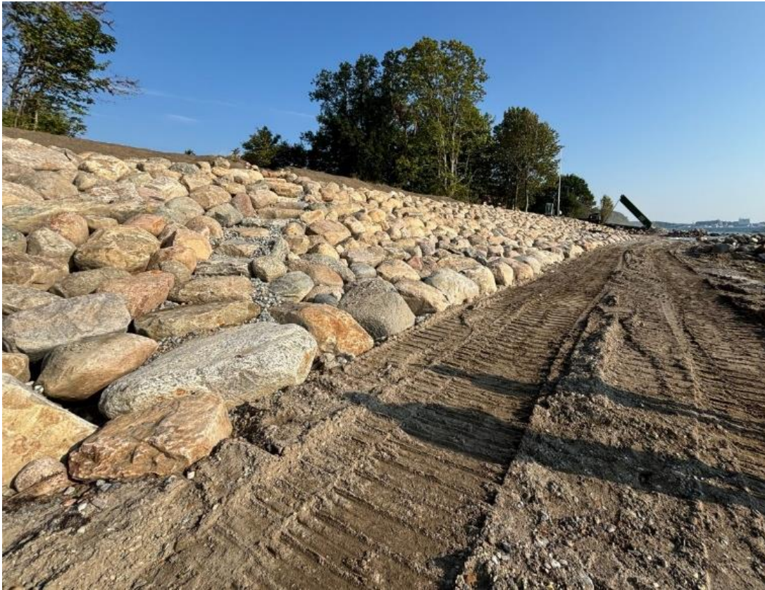
Figur 4-23 Eksempel på tilsvarende kystbeskyttelseskonstruktion med stenkastning op til kote +4,0 m, se profil i Figur 4-24. Bemærk den velanlagte stentrappe
