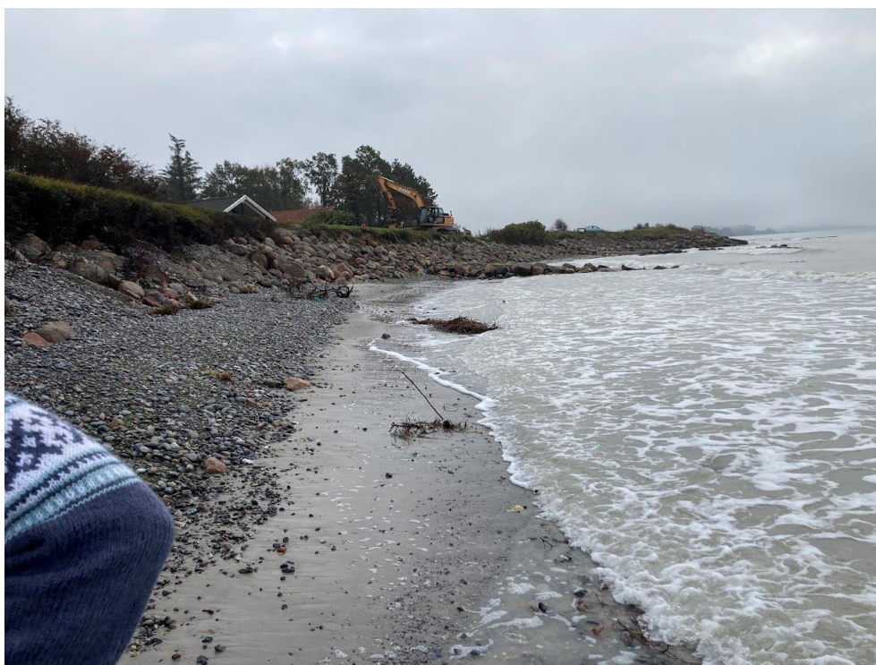
Figur 4-5 Foto af digekronen under stormflodens aftagen. Bemærk kraftig erosion i kronen og mange ral-sten der er flyttet ind over kroen ved kraftigt bølgeoverskyl.
