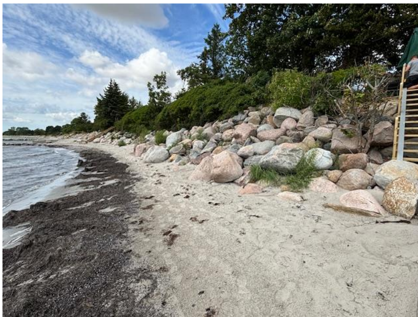
Figur 2-2 Skræntfodsbeskyttelsen mellem høfde 17 og 18, kaldet S 17-18. Man ser den temmelig ujævne stenkastning af store sten i varierende størrelse lagt op mod den naturlige skrænt.
